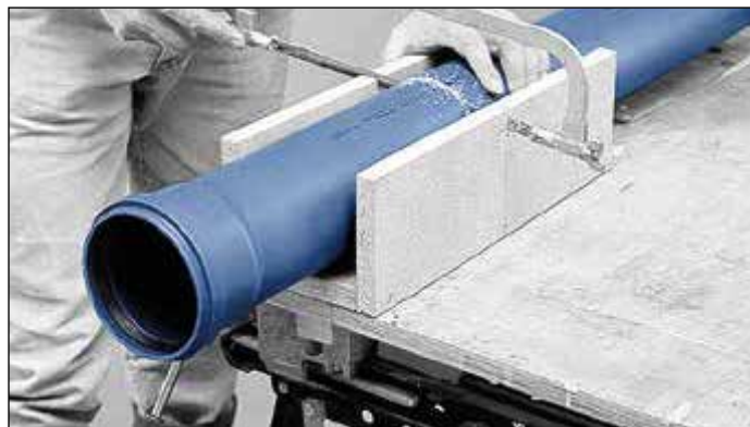
Обрезание до нужной длины пилой с мелкими зубьями
