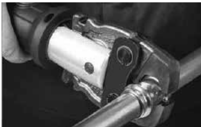
Сборка трубы с фитингом.
