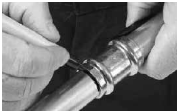
Отмечание глубины вставки.
