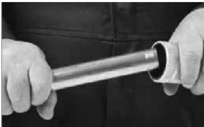
Снятие заусенцев и калибровка.
